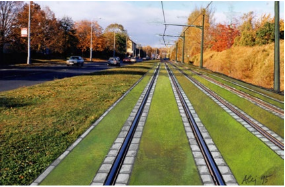
REKONSTRUKCE TRATI V 90. LETECH 20. STOLETÍ BYLA POJATA VELMI ZODPOVĚDNĚ. POD TAKTOVKOU DIPRO, S. R. O., MĚLA SVŮJ DESIGNERSKÝ TÝM, KTERÝ TVOŘILI ING. JIŘÍ PEJŠA, CSC., A ING. ARCH. IVAN LEJČAR. TOTO JE VÝSTŘÍZEK Z DOKUMENTACE, KTERÁ PRACOVALA V HORNÍM ÚSEKU S TEHDY U NÁS POPRVÉ POUŽITÝM ZATRAVNĚNÍM TRATI, NAMÍSTO PEVNÉHO KRYTU Z ASFALTU
