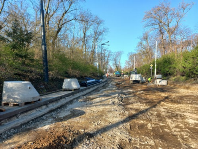
MÍSTO, KDE SE TRATĚ PŘESUNULA O 1,5 METRU VPRAVO. VYBOURÁLO SE VŠE MEZI OBRUBAMI A PŘELOŽILA KANALIZACE
