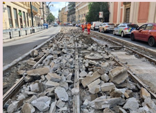
DVA DNY PO ZAHÁJENÍ PRACÍ JIŽ BYL NA NÁRODNÍ TRÍDĚ ODBRÁNĚN ASFALTOVÝ KRYT Z KOLEJÍ I SVRCHNÍ VRSTVA BETONU. KOLEJNICE NA MÍSTĚ ZATÍM ZŮSTÁVALY
