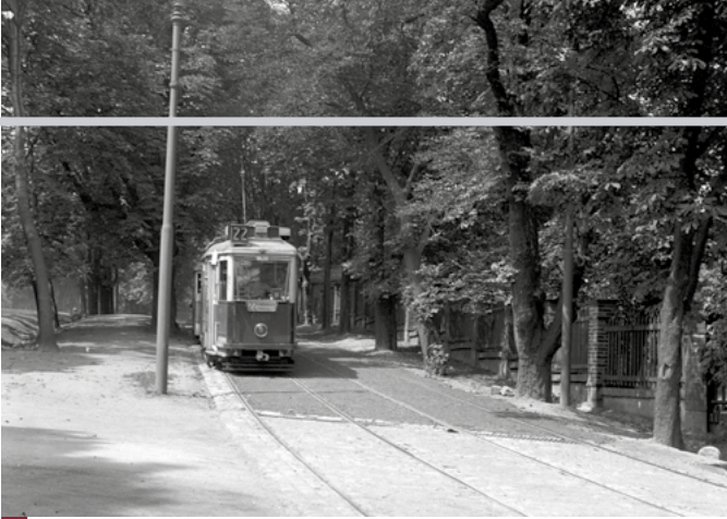
SNÍMEK PŘÍBLIŽNĚ Z ROKU 1960 UKAZUJE USPOŘÁDÁNÍ TRATI V LETECH 1910–1964. JEDNÁ SE O POHLED VE SMĚRU Z CENTRA. TRAMVAJ JEDE OD MÍSTA, KDE JE DNES ZASTÁVKA KRÁLOVSKÝ LETOHRÁDEK. NYNÍ SE PRAVÁ KOLEJ NACHÁZÍ V MÍSTĚ ZDĚNÉHO PLOTU, KTERÝ BYL POSTAVEN ZNOVU O KUS VEDLE. LEVÁ KOLEJ SE POSUNULA DO PŮVODNÍ OSY TRATI
