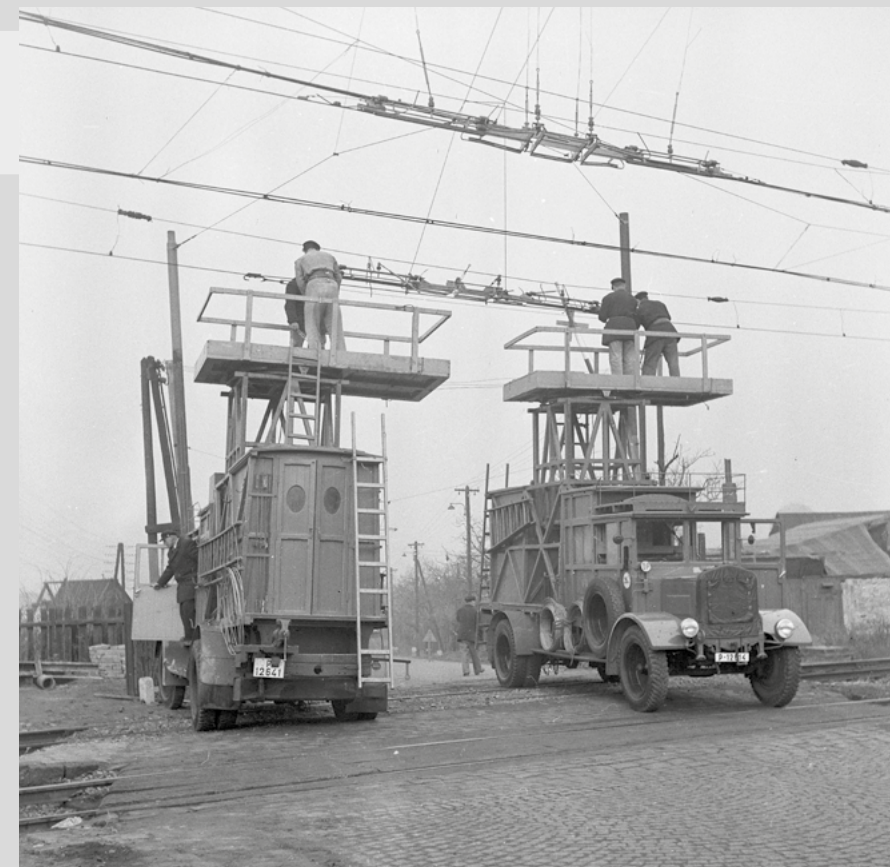
INSTALACE UNIKÁTNÍ TROLEJOVÉ KŘÍŽOVATKY DVOU ELEKTRIFIKAČNÍCH SOUSTAV NA KŘEJCÁRKU
