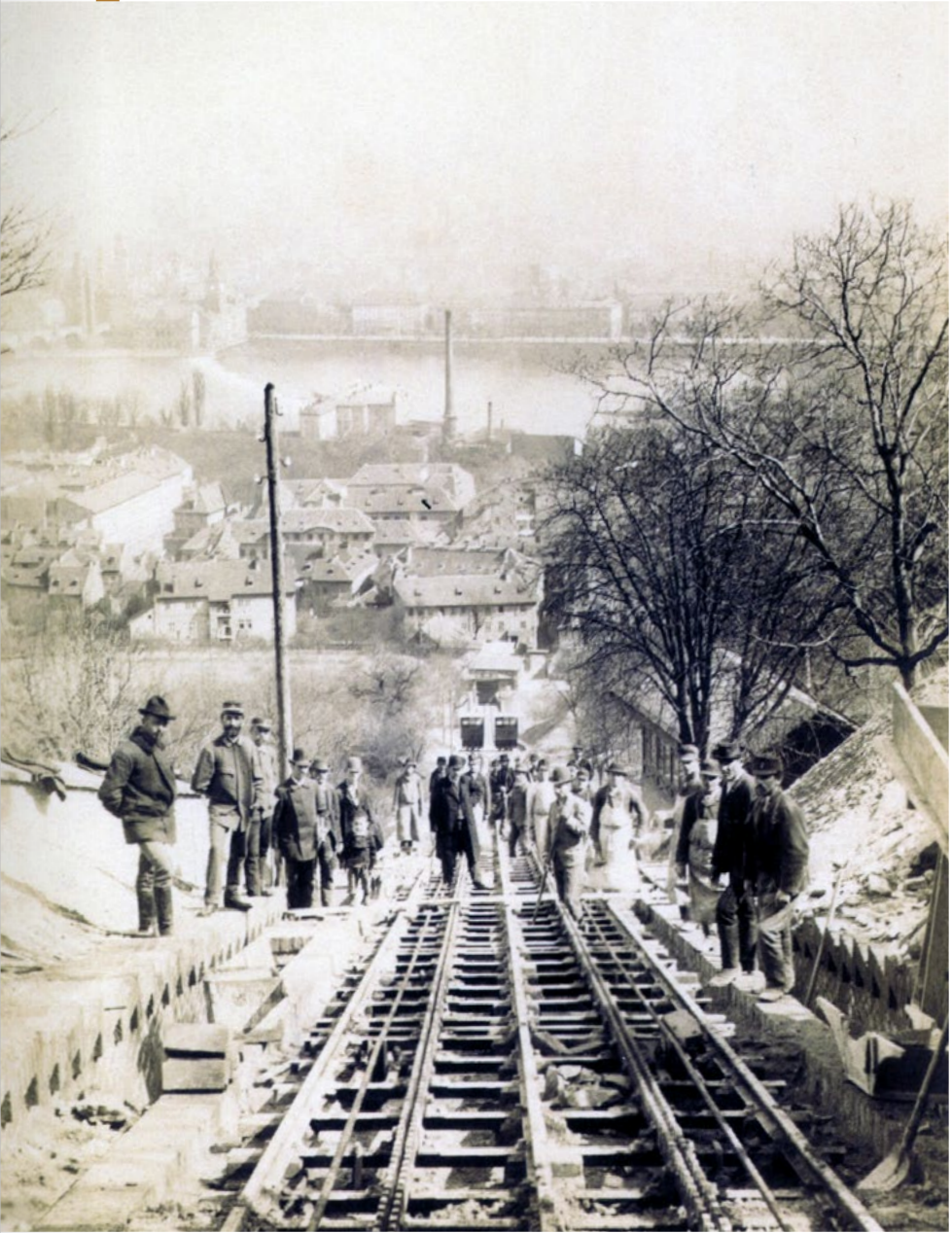
SNÍMEK Z VÝSTAVBY TRATĚ LANOVÉ DRÁHY
