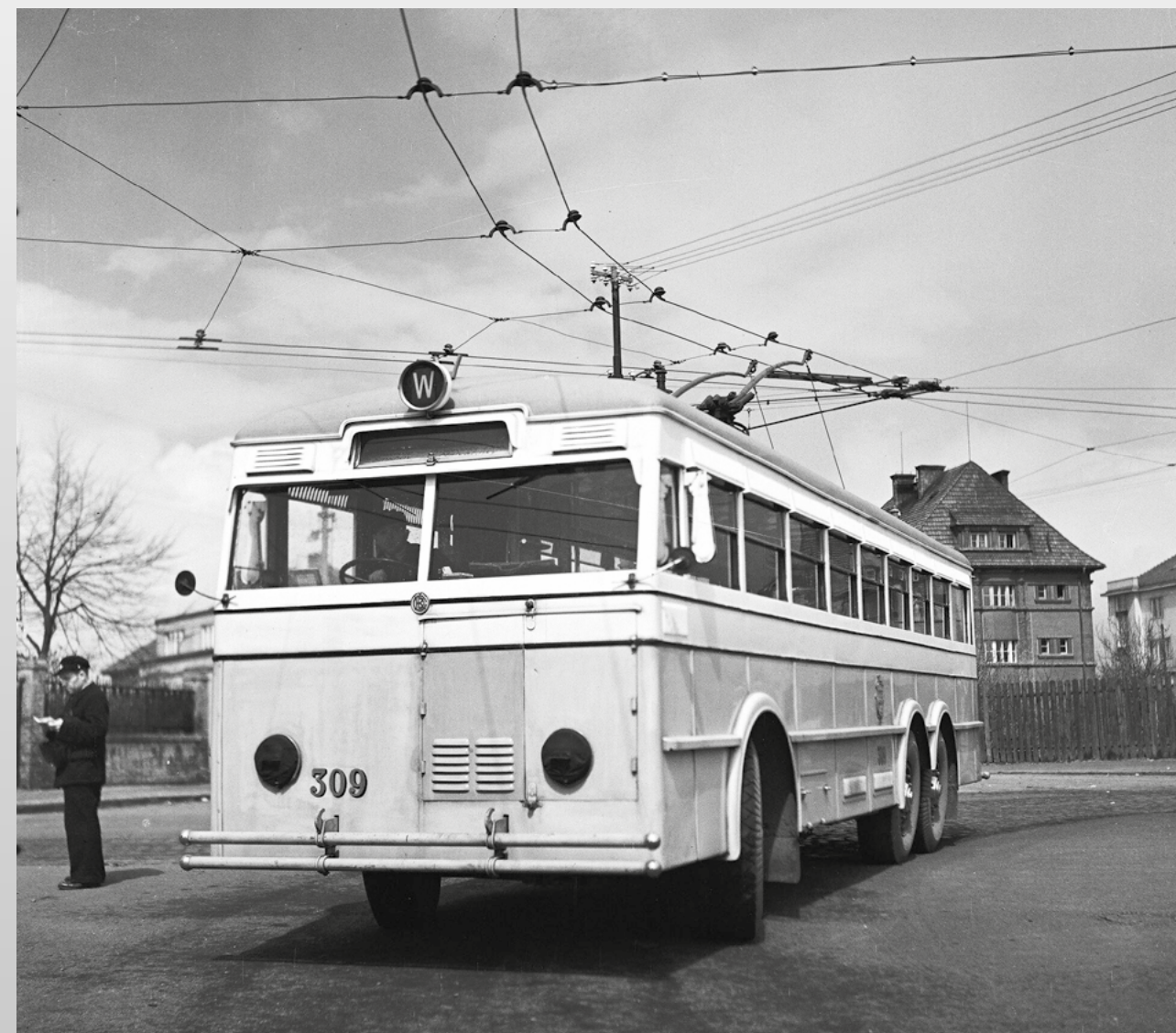
PRAGA TOT EV. Č. 309 NA MALVAZINKÁCH. VŮZ DODANÝ V ROCE 1938 JE ZAJÍMAVÝ MJ. TÍM, ŽE UŽ JE REKONSTRUOVÁN NA PRAVOSTRANNÉ PROVEDENÍ A NA ČELE JE NOVĚ DOPLNĚN PŘÍSTUP DO PŘÍSTROJOVÉ SKŘÍNĚ. VŮZ MÁ TAKÉ ČÁSTEČNĚ VÁLEČNÉ ZATEMNĚNÍ. SBÍRKA: JAN ARAZIM
