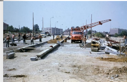
ZNÁMÝ SNÍMEK Z ARCHIVU DPP UKAZUJE ROZESTAVĚNÝ MOST PŘES STAVBU METRA JIŽ BEZ KOLEJÍ, V POZADÍ VIDÍME TROLEJOVÉ STOŽÁRY SMĚREM K RYŠÁNCE
