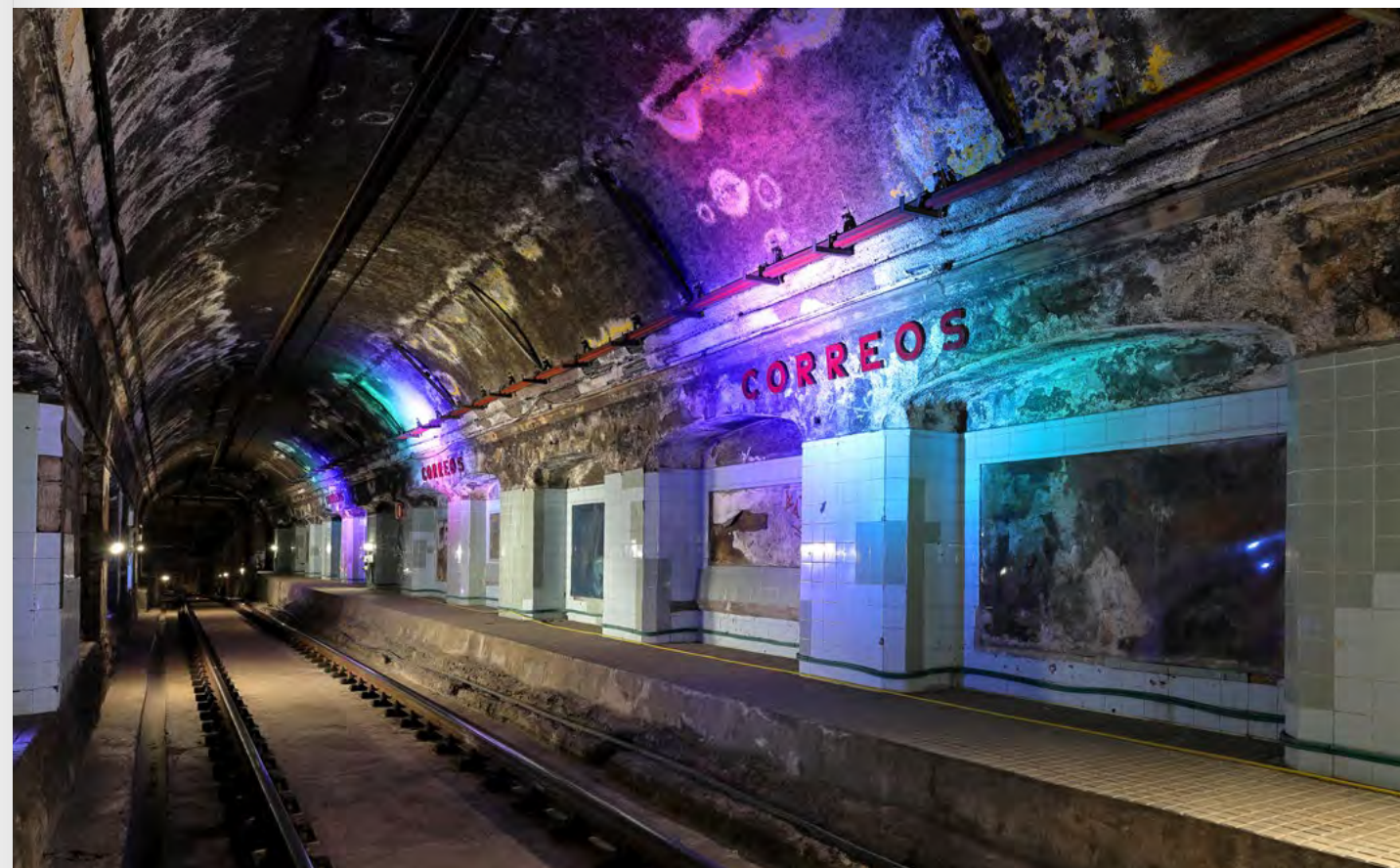
OPUŠTĚNÁ STANICE CORREOS, KTERÁ BYLA V PROVOZU V BARCELONSKÉ SÍTI METRA V LETECH 1934 AŽ 1972
