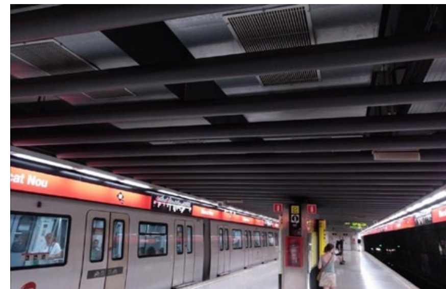
POHLED NA STROPNÍ PRŮDUCHY STANIČNÍ VENTILACE V BARCELONSKÉM METRU ZDROJ: CRONICAGLOBAL.ELESPANOL.COM
