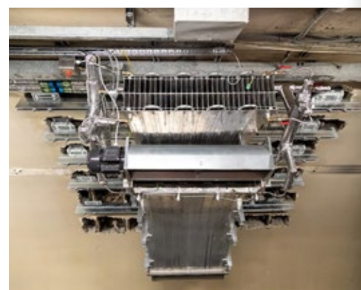
CHLADICÍ PANEL VE ZKUŠEBNÍM PROVOZU VE STANICI LONDÝNSKÉHO METRA HOLBORN ZDROJ: RAILADVENT.CO.UK
