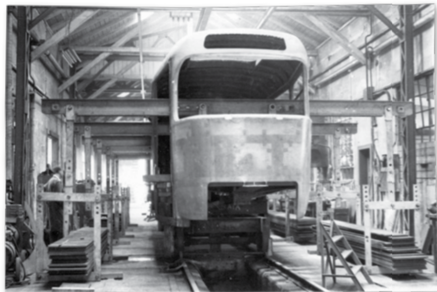
STATICKÁ ZATĚŽOVACÍ ZKOUŠKA HRUBÉ STAVBY PROTOTYPU T III V PROTOTYPOVÉ DÍLNĚ NA ZLÍCHOVĚ (DNES TYTO DOSUD EXISTUJÍCÍ PROSTORY VYUŽÍVÁ SPOLEK VÝTOPNA ZLÍCHOV) DNE 8. 6. 1960. JIŽ ZA TŘI MĚSÍCE SE VŮZ PŘEDSTAVIL VEŘEJNOSTI V PLNĚ KRÁSE NA VELETRHU V BRNĚ SBÍRKA: ROBERT MARA
