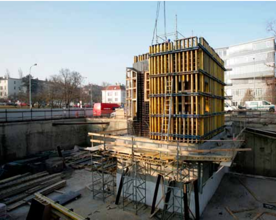
Pohled na větrací objekt v hloubené části zařízení staveniště EI – Kanadská.
