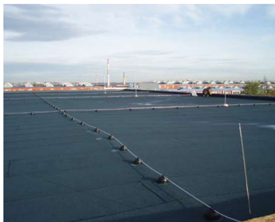
Střecha na centrálním skladu v Opravně tramvají v hostivařském areálu před a po opravě.
