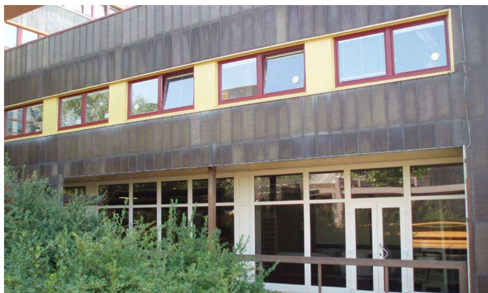
Ukázka z činnosti odboru: stav budovy A hostivařského depa po výměně oken a před tím.
