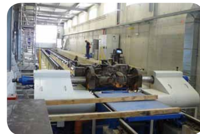
V hloubětínské vozovně byl nedávno instalován nový podúrovňový soustruh
