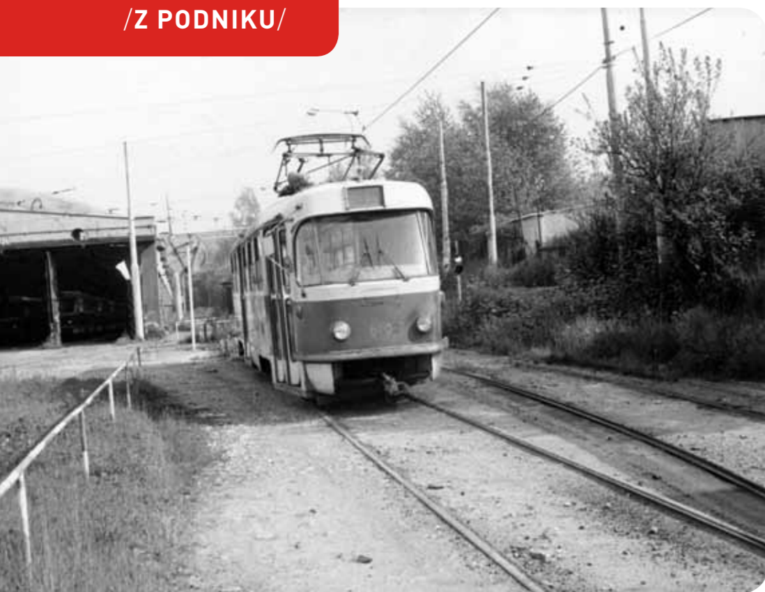
Historický snímek z vozovny Hloubětín zachycuje vůz typu T3 č. 6102 na 26. koleji, kde je dnes hala denního ošetření
