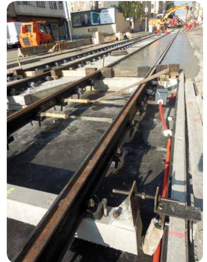
Postup prací v Dělnické. V přední části jsou obnažené koleje a chránička pro vzdálené rádio. Vzdudu je čerstvě zabetonováno
