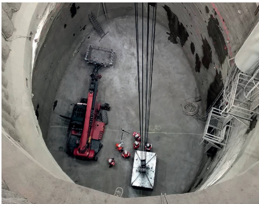
Foto dokončené šachty pro výstavbu stanice SO 13-13 z ohlubeně.
