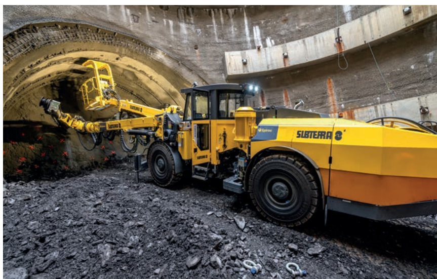
Zahájení ražeb SO 11-14 ze šachty PAD1b.
