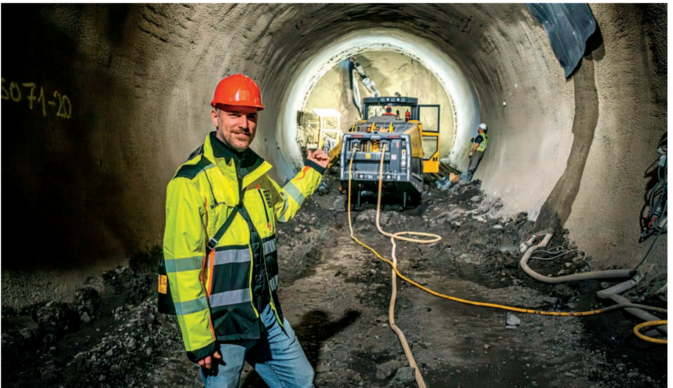
U příležitosti prvního výročí zahájení stavby metra D letos v dubnu navštívil Zdeněk Hřib místo aktuální ražby.
