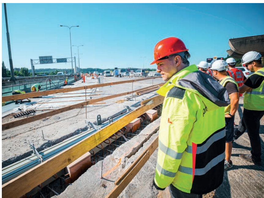
Zdeněk Hřib na kontrolním dnu staveniště Barrandovského mostu.
