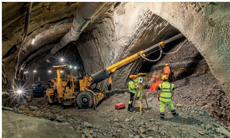
Zahájení ražeb kaloty PDV stanice Pankrác SO 11-20 z PAD4 + schéma členění stanice.
