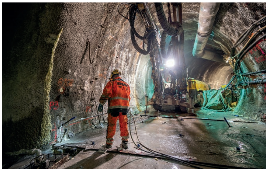
Chemická injektáž přestupní chodby SO 11-23.
