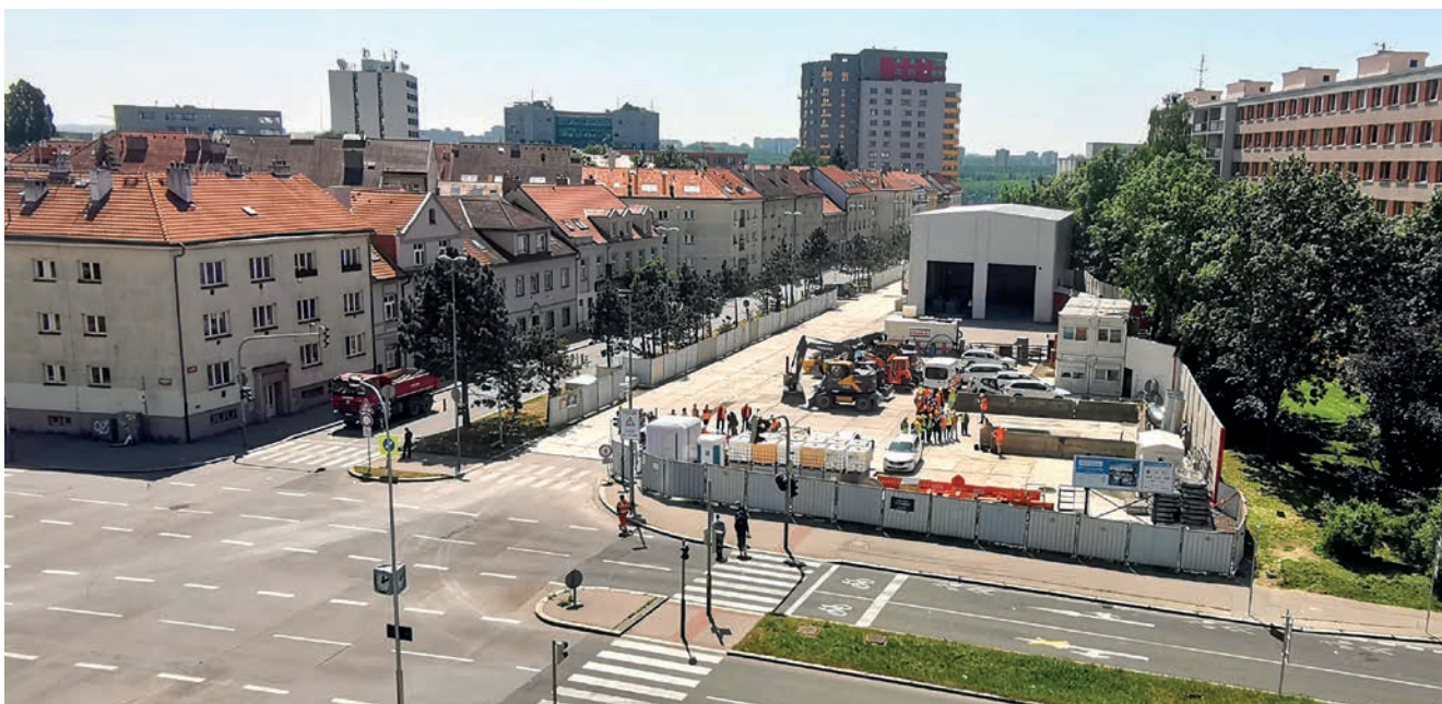
Staveniště stanice Olbrachotva OL2 s protihlukovou halou.
