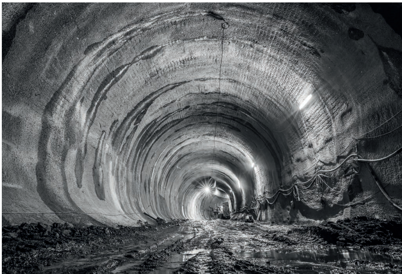
Jednokolejný traťový tunel u stanice Olbrachtova – dokončená ražba.
