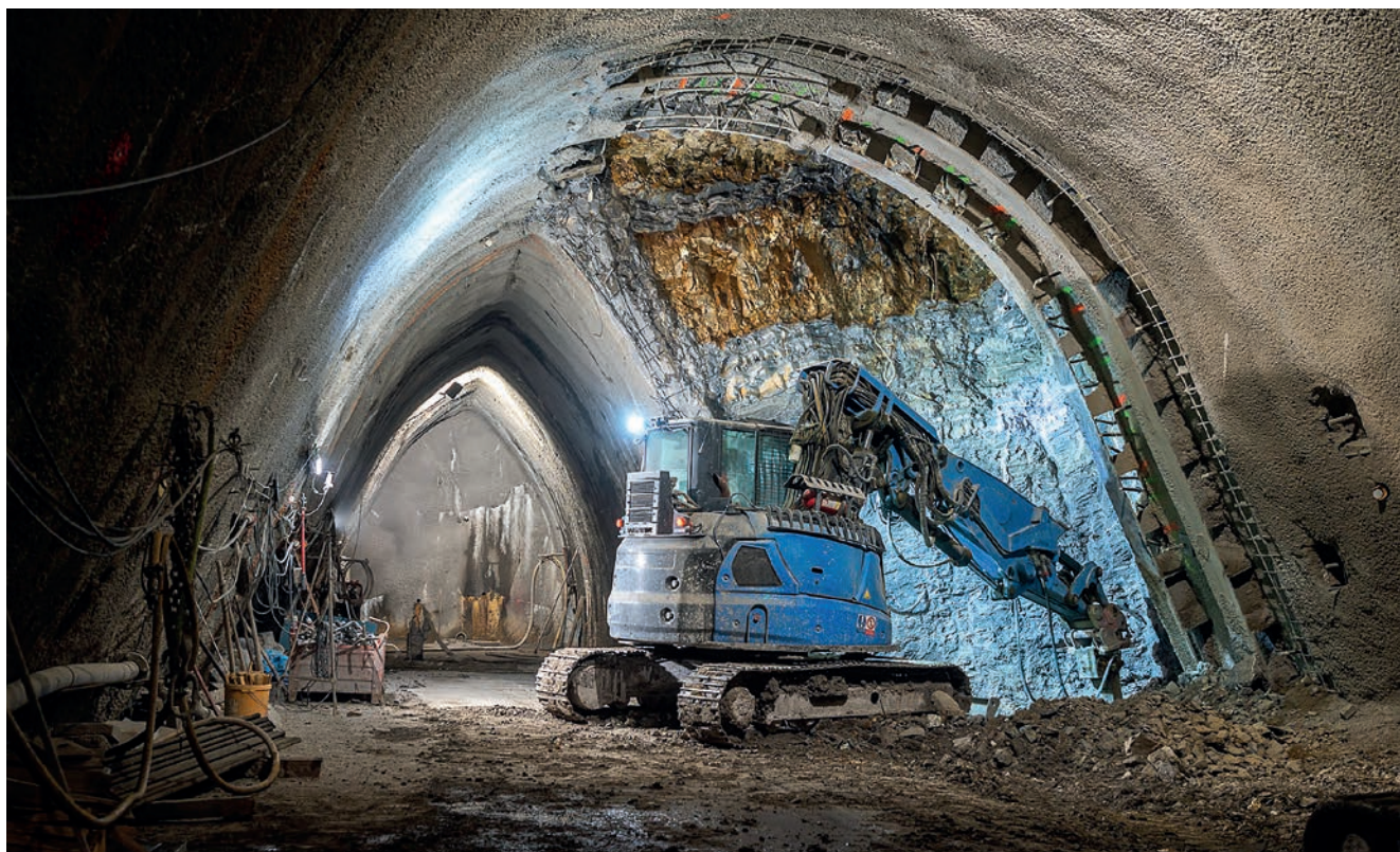
Ražba pravé strany profilu patní štolý stanice Pankrác SO 11-20, tunelový bagr WIMMER Blue badger.
