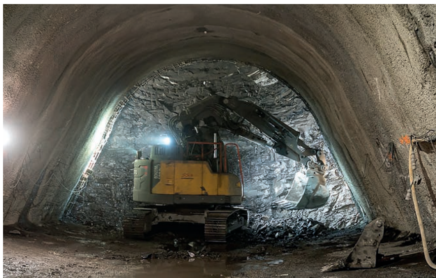
Ražba plného profilu patní štolý stanice Pankrác SO 11-20, rameno tunelového bagru VOLVO ECR235.
