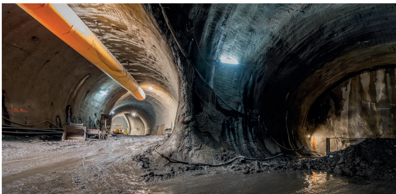
Rozražení SO 11-14 na část přístupovou (vpravo) a část vzduchotechnickou (vlevo), kde na konci již probíhá ražba 1. dílčího výrubu technologického bloku SEVER (SO 11-15).
