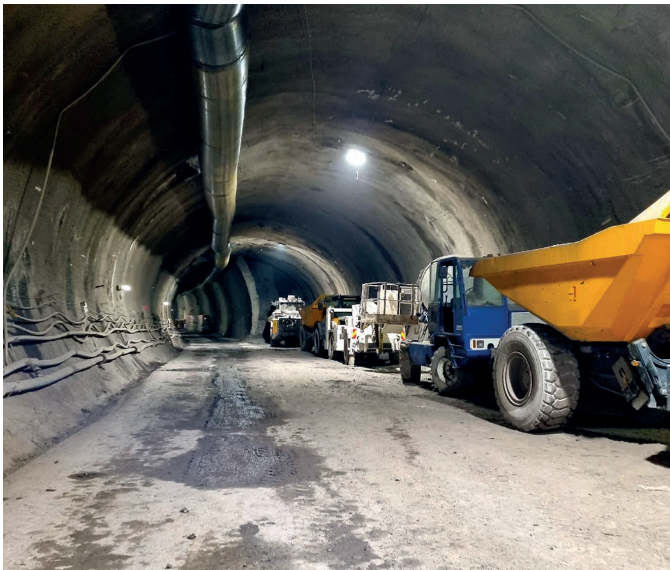
Dvojkolejný traťový tunel u stanice Pankrác – dokončená ražba.
