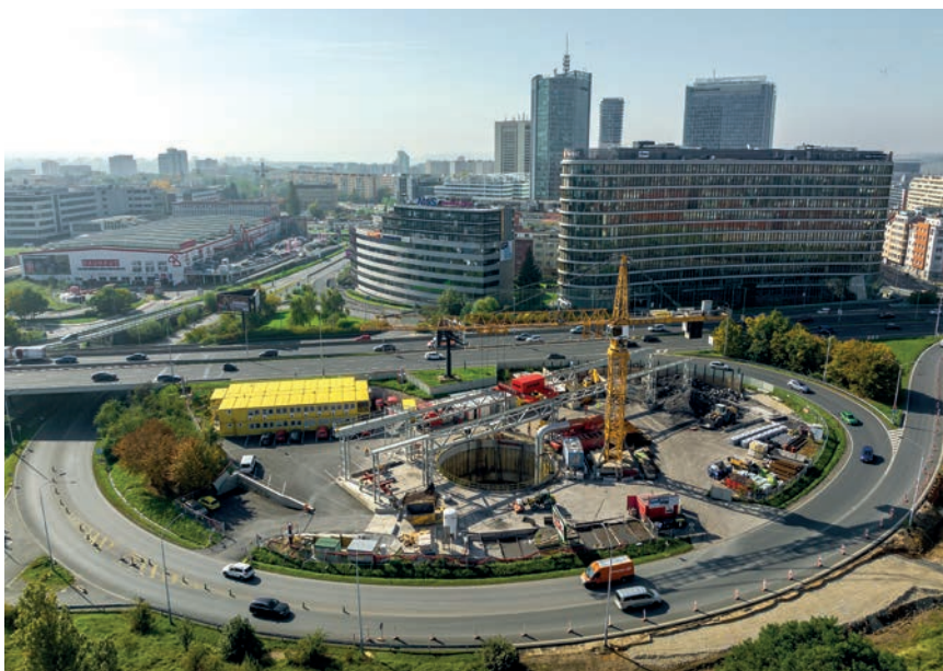
Hlavní staveniště pro ražbu stanice Pankrác, tj. ZS PAD1b.
