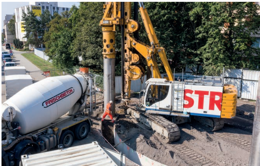
Betonáž piloty vyvrtané do vodící šablony.
