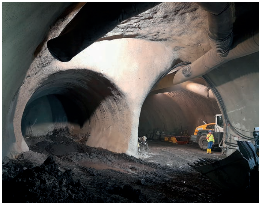
Ražba rozpletu tunelů v úseku Pankrác–Olbrachtova.
