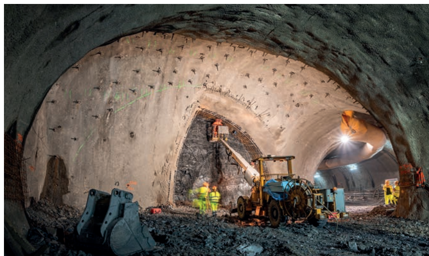
Rozrážka dvoukolejného tunelu SO 11-28 směr demontážní komora, vpravo zaústění technologického tunelu SO 11-15.
