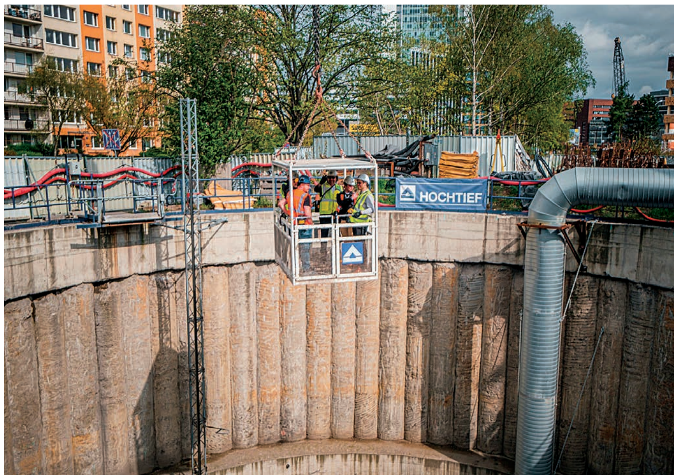
Hloubení šachty pro ražby budoucí stanice Olbrachtova.
