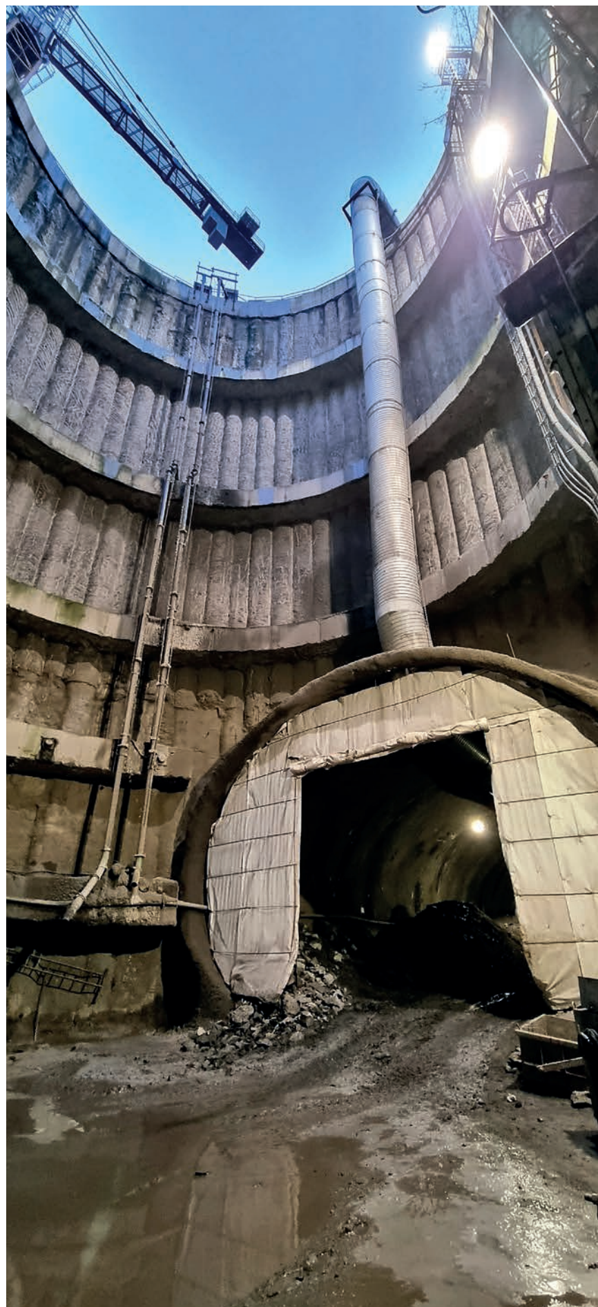
Šachta VO-OL pro výstavbu mezistaničního úseku Pankrác–Olbrachtova.
