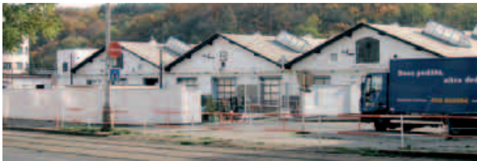
Tak vypadal areál košířského učiliště před dvěma lety, 25. října 2004. Když kdysi ještě stála administrativní budova, takovýto pohled na vozovnu nebyl možný.
