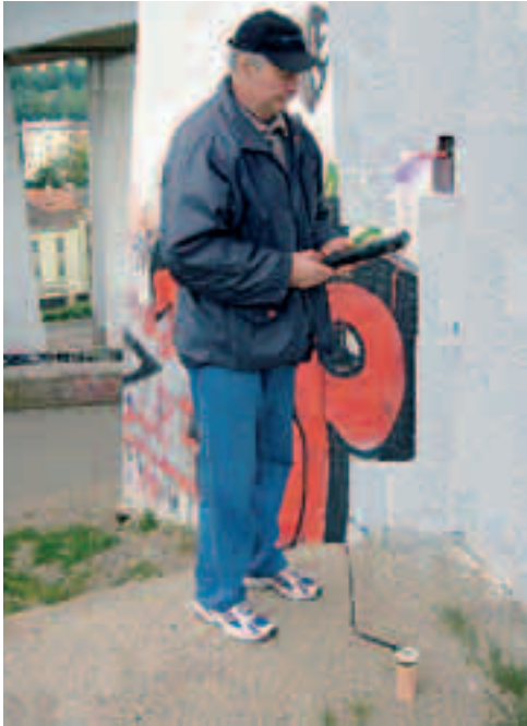
Měření na konstrukci Nuselského mostu.
