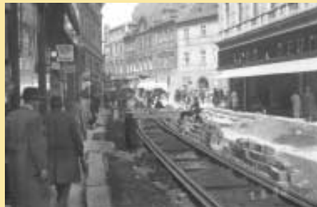
Stavba splítky v Celetné ulici v květnu 1938. Foto: sbírka autora
