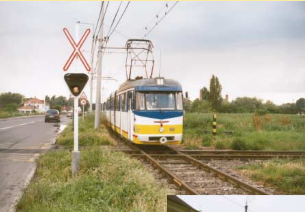
Szeged, úrovnňový přejezd jednokolejné linky č. 3 a rychlíkové železniční trati v červenci 2001.
