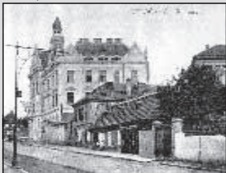
Pokud byste vyšli z naší budovy před 89 roky, naskytl by se vám pohled na zbrusu novou radnici. Těžko tehdy někomu napadlo, že tu jednou bude vestibul stanice metra.
