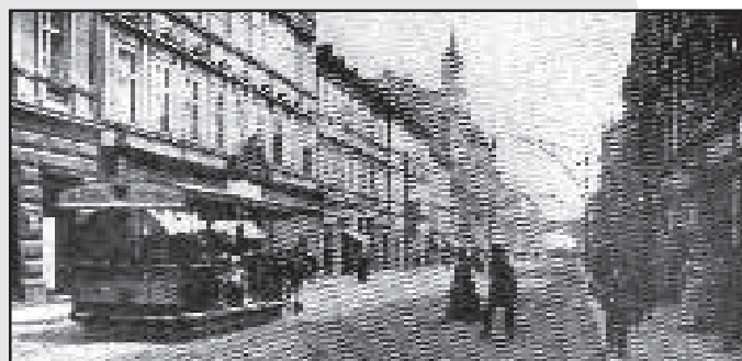
Tak vypadala Královská třída v Karlíně po roce 1895, kdy v ní bylo na zvláštních bránách instalováno elektrické osvětlení. Vozy koňky tu v té době začínaly jezdit už třetí desetiletí.
