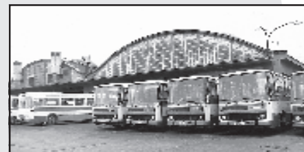
Autobusová garáž Vršovice v roce 1985. Původně byla v roce 1955 postavena jako trolejbusová vozovna
