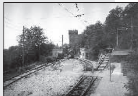
Konec úseku s 25 procentním sklonem. Vpravo na obrázku je kolej umístěná do svahu, jejímž úkolem je zastavit vůz kterému selhaly brzdy při jízdě z Opiciny k moři. Zajímavostí je výhybka k čekající lokomotivě, která se přestaví až po zastavení tramvaje na zastávce.
