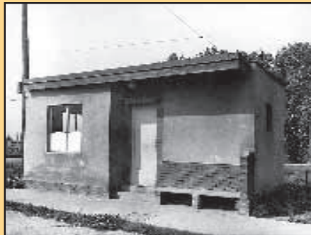
Jeden z prvních zděných objektů se sociálním zařízením a současně s dispečerským pracovištěm ve stanicích Ledárny kolem roku 1935.
