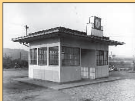
Rozebíratelný přístřešek se záchodem pro zaměstnance ve smyčce Hloubětín kolem roku 1937.
