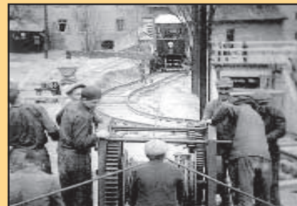
Každého člena Kroužku městské dopravy pochoptelně vždy uchvátily archivní filmové záběry. Tak zachytil dobový kameraman například přepravu nových vozů lanové dráhy v roce 1932. Technické pomůcky hlavních aktérů? Vozík pod vagónem, navíják na ruční pohon a provizorní kolej. Foto: sbírka Pavla Fojtíka
