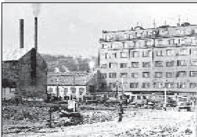
Tento snímek se velmi podobá dnešnímu stavu. Jenže Tatrovka už také nestojí a objekt, postavený při stavbě prvního provozního úseku tratě B místo domů U zlatého anděla, dnes z větší části už zmizel také v minulosti. Foto: Skala, Pragocar
