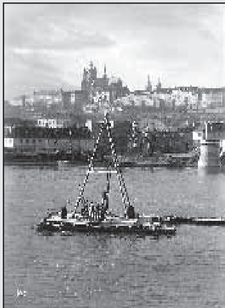
Vrtání základových sond pro tunel podzemní dráhy pod řečištěm Vltavy 28. listopadu 1939.
