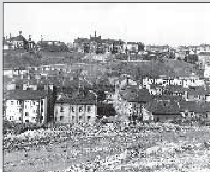
Pamatujete ještě vůbec Nuselské údolí bez mostu? V roce 1965, kdy byl pořízen tento snímek už probíhaly první přípravné stavební práce a do zboření domů na Karlově a ve Svatoplukové ulici už mnoho času nezbývalo. Foto: Josef Mikšátko
