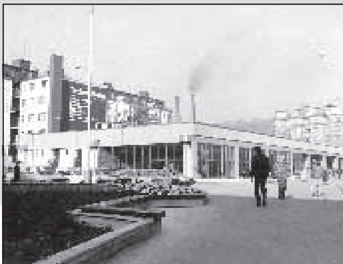
Dnes se u Anděla prolétáme mezi ohradami, a víme, že se tu staví. A snad už si při postupném mizení vestibulu zdejší stanice už ani pořádně nevybavíme, jak to tu vlastně ještě před nedávnem vypadalo. Už je to jinak... Foto: J. Hussarová
