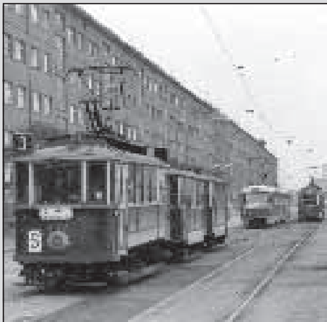
Z některých míst 9. května 1974 zmizely nejen staré tramvaje, ale tramvaje vůbec. Dnes je v Budějovické ulici na tramvajovém tělese jen parkoviště několika stovek automobilů. Foto: Ing. I. Mahel. 27.9.1973
