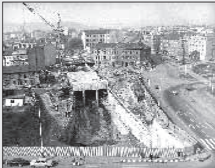
Staveniště stanice Pražského povstání na prvním provozním úseku tratě C.
