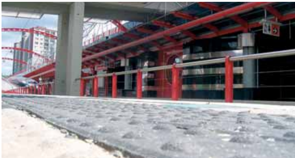
Vodící čáry jsou nahrazeny zvláštními „hrbolatými“ dlaždicemi.
