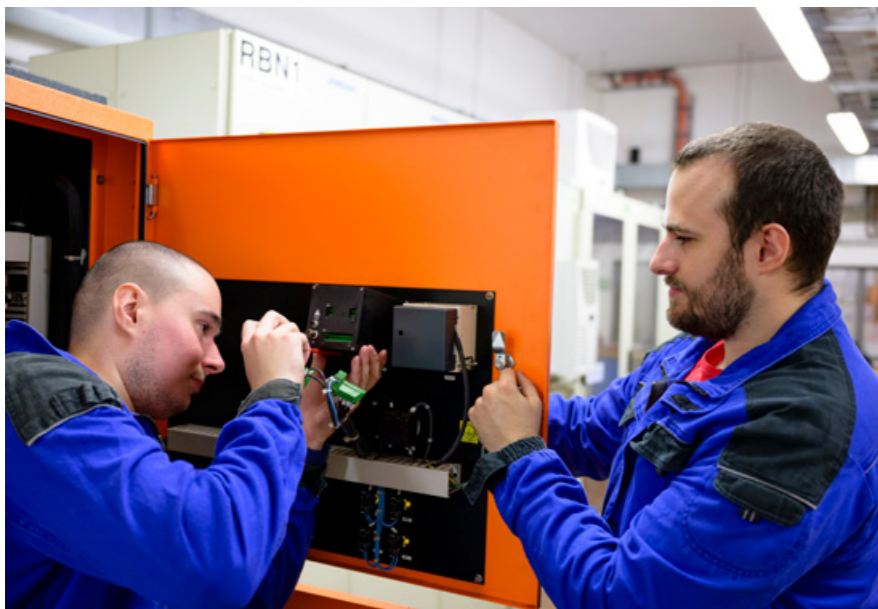
BRATŘI PŘI MONTOVÁNÍ NADPROUDOVÉ OCHRANY V NAPAJEČOVÉM RYCHLOVYPÍNAČI (NRV), TEDY PRO STEJNOSMĚRNÉ NAPĚTÍ 825 V
