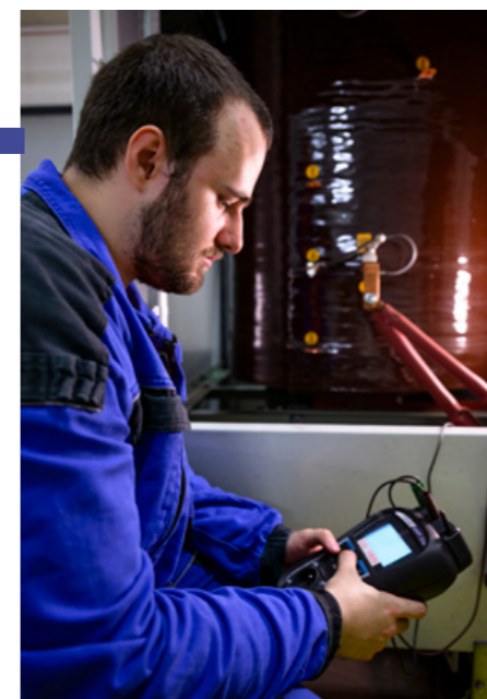
MARTIN PŘI MĚŘENÍ IZOLAČNÍHO STAVU TRANSFORMÁTORU...
