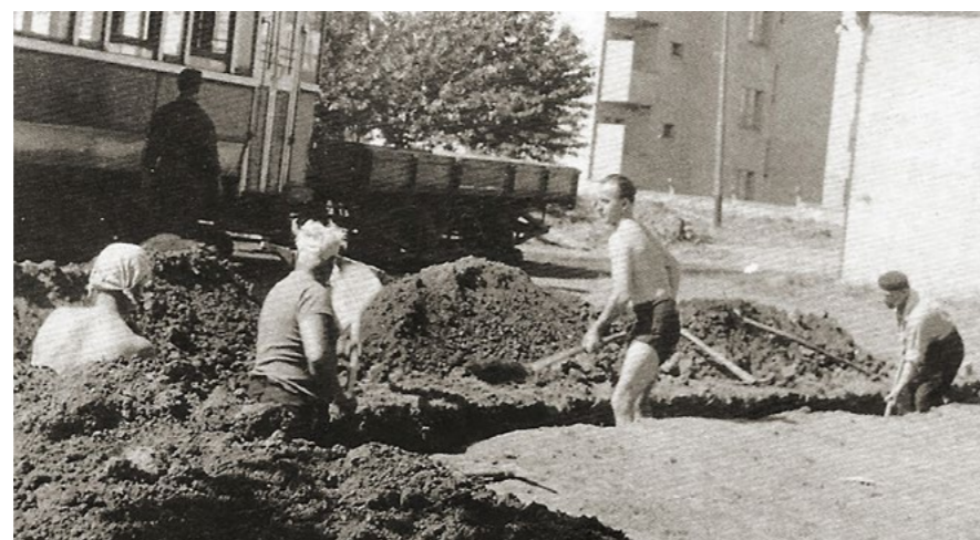
Z ROKU 1953 JE TENTO ZÁBĚR Z KOPÁNÍ ZÁKLADŮ PŘÍSTAVKU PRO CIVILNÍ OBRANU S GARÁŽÍ
