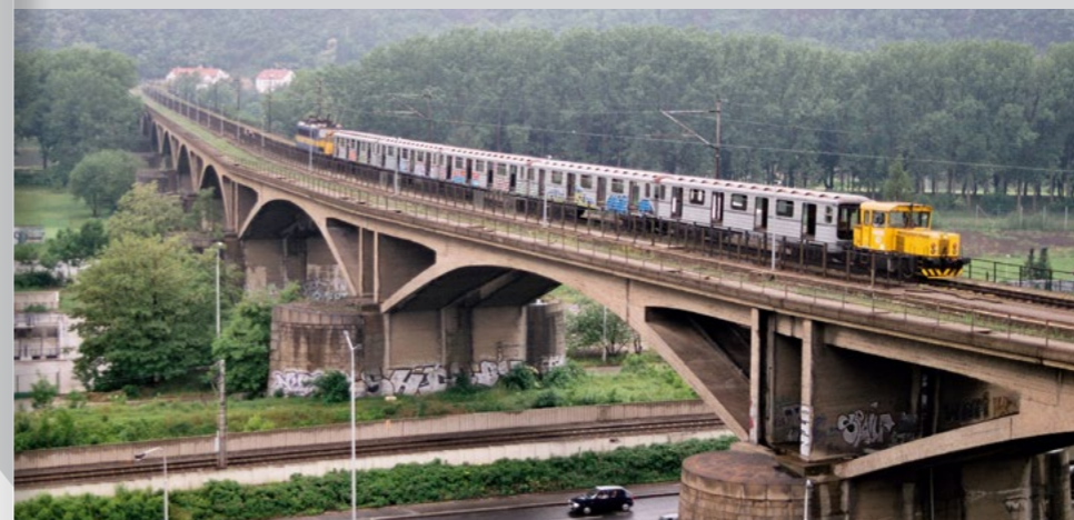
TAKTO DAVID PROSICKÝ V ČERVNU 2004 ZAZNAMENAL PŘEVOZ SOUPRAVY 81-71 NA REKONSTRUKCI DO PLZNĚ
