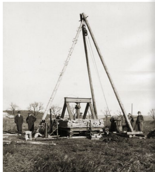
NEOBVYKLÁ ČINNOST PŘED ZAHÁJENÍM STAVBY – ZATĚŽOVACÍ ZKOUŠKY BUDOUCÍHO STAVENIŠTĚ – BYLA VE VOKOVICÍCH TŘEBA
