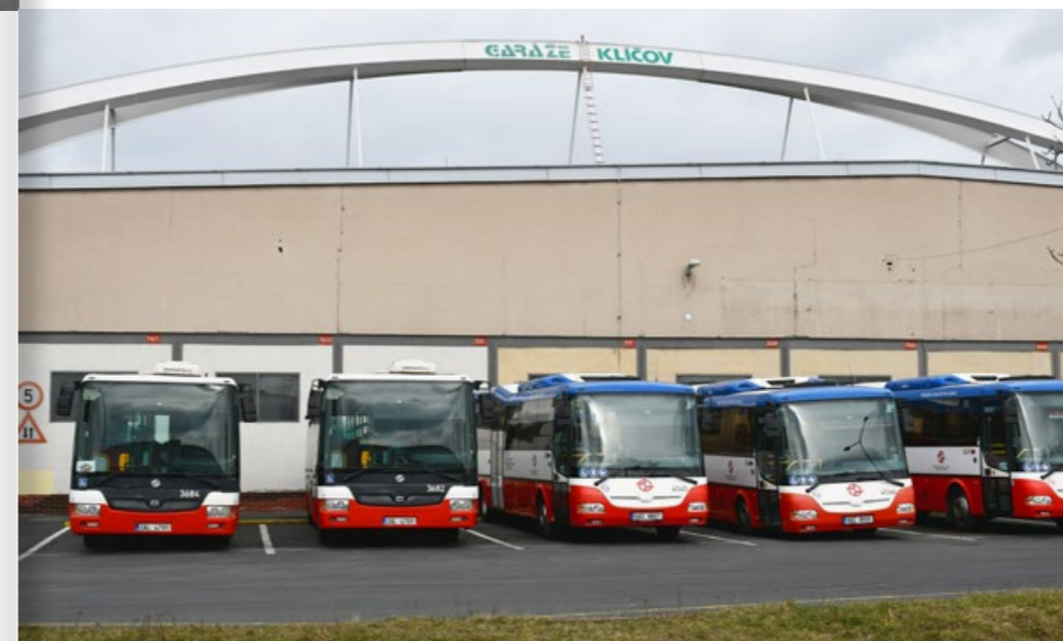
KDY A PROČ SE V PROJEKTU GARÁŽE PŘISTOUPILO NAMÍSTO KONSTRUKCE STŘEŠY ZAVĚŠENÉ NA OCELOVÝCH LANECH KE DVĚMA DVOJICÍM ŠIKMÝCH OBLOUKŮ, PSAL UNOROVÝ DP KONTAKT
