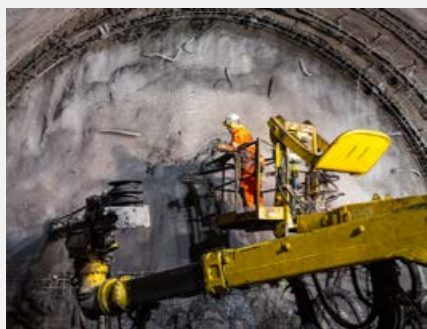
STAVBA ÚSEKU PANKRÁC – OLBRACHTOVA BYLA ZAHÁJENA
