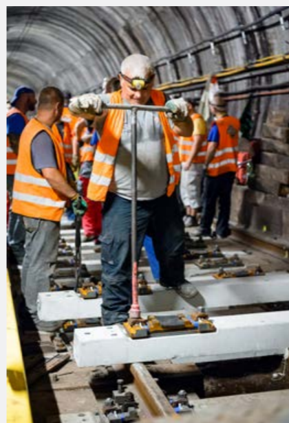
MNOHALETÝ PROJEKT VÝMĚNY DŘEVĚNÝCH PRAŽCŮ NA TRASE C POKRAČUJE
