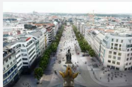
TRÁŤ NA VÁCLAVÁKU MÁ STAVEBNÍ POVOLENÍ
