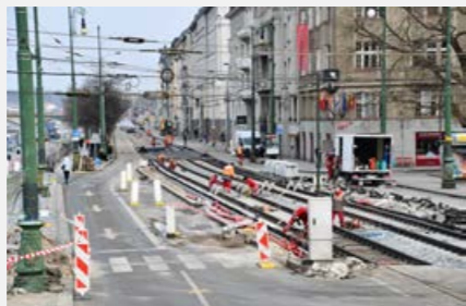
MODERNIZACE TRATI NA RAŠÍNOVÉ NÁBŘEŽÍ
