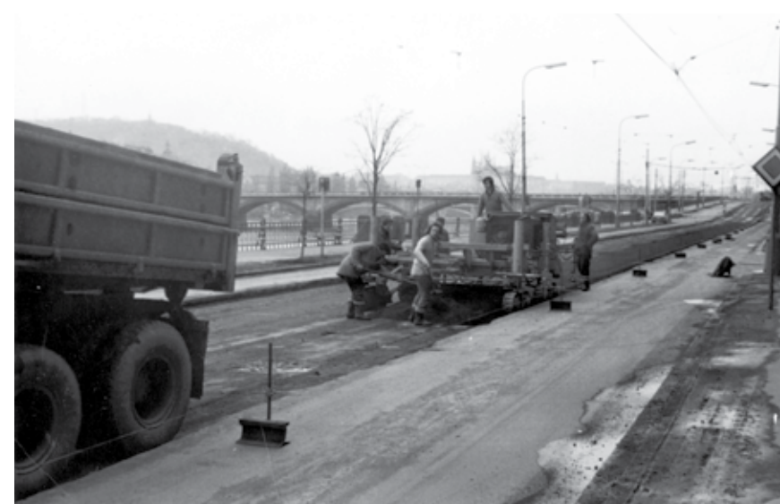
JSME V ROCE 1979 A NA SNÍMKU Z ARCHIVU DPP VIDÍME ZŘÍZOVÁNÍ PODKLADU NA PŮVODNÍ BETONOVÉ DESCE PRO PRVNÍ GENERACI BKV PANELŮ
