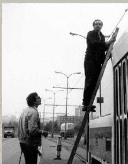
... NA ŽEBŘÍKU PŘI OPRAVĚ KÁTĚČKA NA TRATI V ČERNOKOSTECKÉ ULICI...
