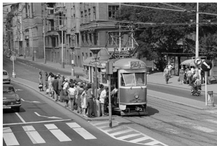
SNÍMEK TRAMVAJE T1 NA VÝTONI POŘÍDIL JAROSLAV KOVÁŘ A DNES JE SOUČÁSTÍ SBÍRKY TOMÁŠE DVOŘÁKA. SNÍMEK BUDE Z PŘELOMU 60. A 70. LET. TRÁŤ JE ČERSTVĚ PO REKONSTRUKCI A NA VÝTONI JIŽ JSOU MODERNÍ SEMAFORY SIGNALBAU HUBER MNICHOV. REFÝŽE JSOU O NĚCO DELŠÍ NEŽ POUZE NA SOUPRAVU 2xT3. NA OZNAČNÍCÍCH TYPU „TRYCHTÝŘ“ ZATÍM NENÍ LINKA 32, KTERÁ ZAHÁJILA SVŮJ PROVOZ AŽ 30. SRPNA 1971
