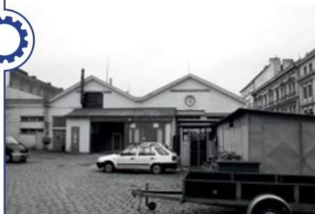
Vozovna Smíchov v ulici Na Valentince
