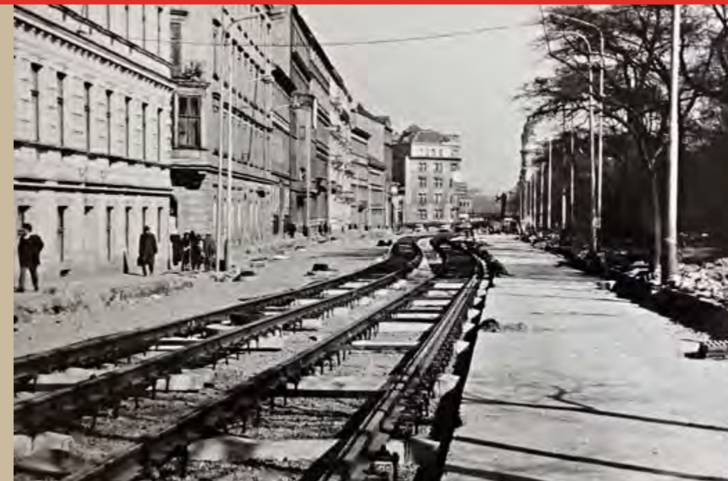
TRATĚ V OPLETALOVÉ ULICI, I KDYŽ BYLA OD POČÁTKU JEN PROVIZORIEM, BYLA POSTAVENA NA BETONOVÉ DESCE S REKTIKACÍMI PRAČI, KTERÉ BYLY NÁSLEDNĚ ZABETONOVÁNY. ULICI VNÍMÁME JAKO PŘÍMOU, ALE VE SKUTEČNOSTI SE MÍRNĚ LOMÍ A NAVÍC I JEJÍ ŠÍŘKA JE PROMĚNLIVÁ, ČEMUŽ SE MUSELO PŘÍPŮSOBIT I SMĚROVÉ VEDENÍ KOLEJÍ. FOTOGRAFIE JIŘÍHO ČERMÁKA UKAZUJE PRŮBĚH STAVBY 12. BŘEZNA 1972
