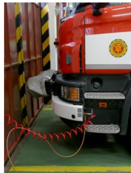
STARŠÍ SYSTÉM DOBÍJENÍ A PŘÍVODU STLAČENÉHO VZDUCHU
