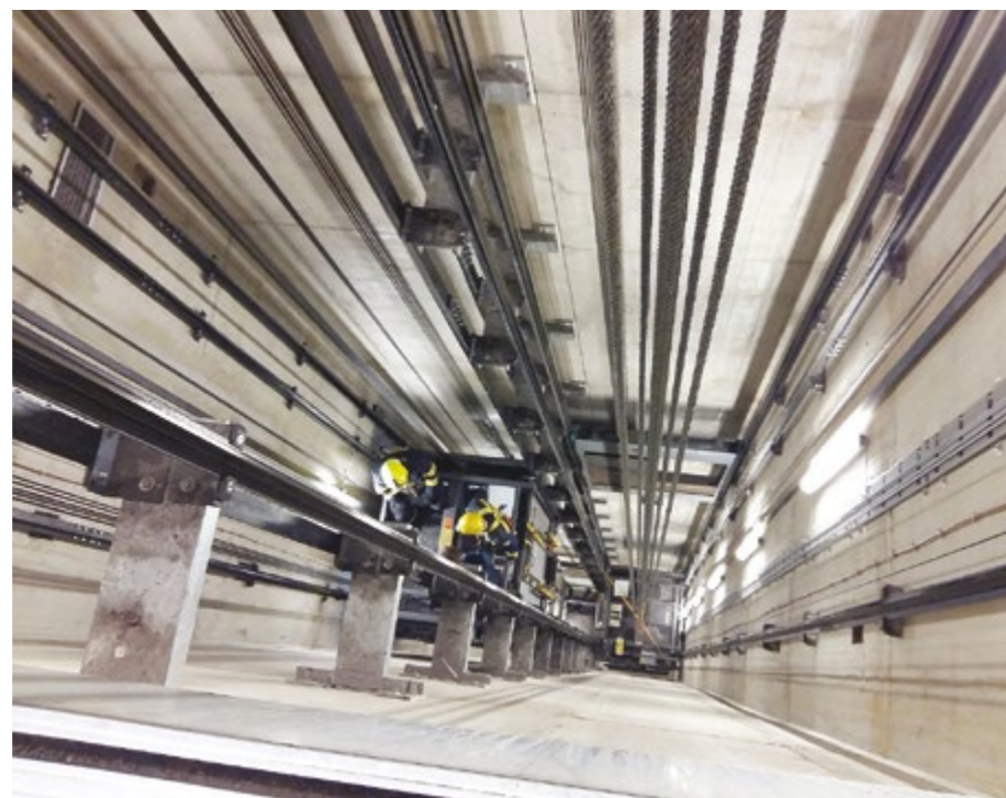
ZÁSAH 396., STANICE MĚTRA BOŘISLAVKA – TECHNICKÝ ZÁSAH ; OSOBY UVĚZNĚNÉ VE VÝTAHU: LEZECKÁ SKUPINA HZS DP PŘEVĚDLA SLANĚNÍ NA KABINU VÝTAHU, ČTYŘI CESTUJÍCÍ VYPROŠTĚNI A ODVEDENI PO NOUZOVÉM SCHODIŠTI, VÝTAH PONECHÁN MIMO PROVOZ
