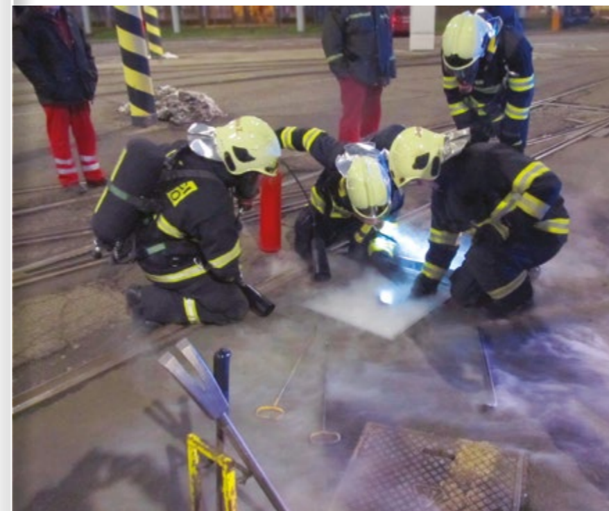
VÝJEZD Č. 93, VOZOVNA STRAŠNICE – POŽÁR KABELÁŽE OHŘEVU VÝMĚNY: OHNÍSKO POŽÁRU VYHLEDÁNO POMOCÍ TERMOKAMERY, POŽÁR LOKALIZOVÁN OXIDEM UHLÍČITÝM ZE SNĚHOVÉHO HASIČÍHO PŘÍSTROJE A PO VYPNUTÍ EL. ENERGIE LIKVIDOVÁN VYSOKOTLAKÝM VODNÍM PROUDEM, ZÁSAH PŘEVĚDĚN V DÝCHACÍ TECHNICI
