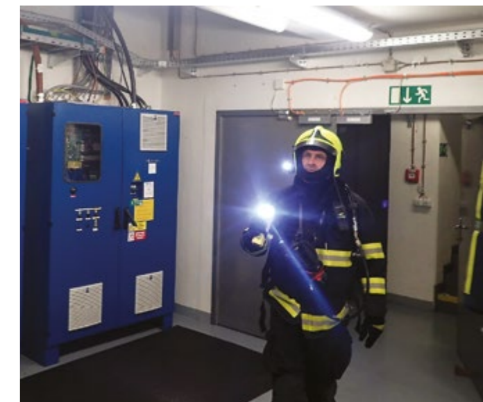
VÝJEZD S ČÍSLEM 411, STANICE MĚTRA PETŘINY – TECHNICKÝ ZÁSAH ; ZAKOURENÍ STROJOVNY ESKALÁTORU: K PRŮZKUMU POUŽITA TERMOKAMERA, ZJIŠTĚNO PŘEHŘÁTÍ BRZDNÉHO REZISTORU, PŘEVĚDENO PŘIROZENÉ ODVĚTRÁNÍ PROSTORU
