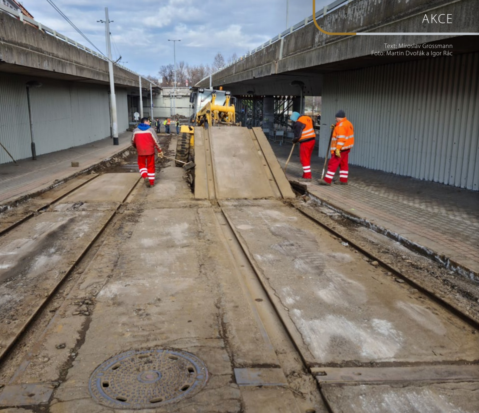
NA VLTAVSKÉ SE V PRVNÍCH DNECH VÝLUKY NEJPRVE ODSTRAŇOVÁLY VELKOPLOŠNÉ PANELY
