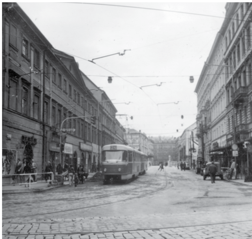
JIŽ ZPROVOZNĚNÁ PANELOVÁ TRATĚ V HAVLÍČKOVĚ ULICI ZJEVNĚ V PRVNÍ ETAPĚ PROVOZU, TEDY CCA 2. ČTVRTLETÍ 1983. OBLOUKY K NÁMĚSTÍ REPUBLIKY JEN ZALOŽENY. SEMAFORY JIŽ NEFUNKČNÍ, DNES NAŠTĚTÍ JSOU ZCELA ZRUŠENÉ. FOTO: ARCHIV DPP, JIŘÍ KIRNIG
