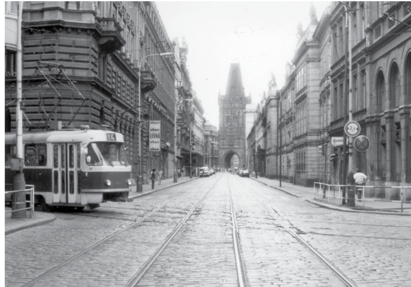
SNÍMEK (PRAVDĚPODOBNĚ) PAVLA FOJTÍKA ZE 4. SRPNA 1985 UKAZUJE OSIŘELOU TRATĚ V HYBERNSKÉ ULICI A KŘÍŽENÍ S DLAŽDĚNOU A HAVLÍČKOVOU ULICÍ
