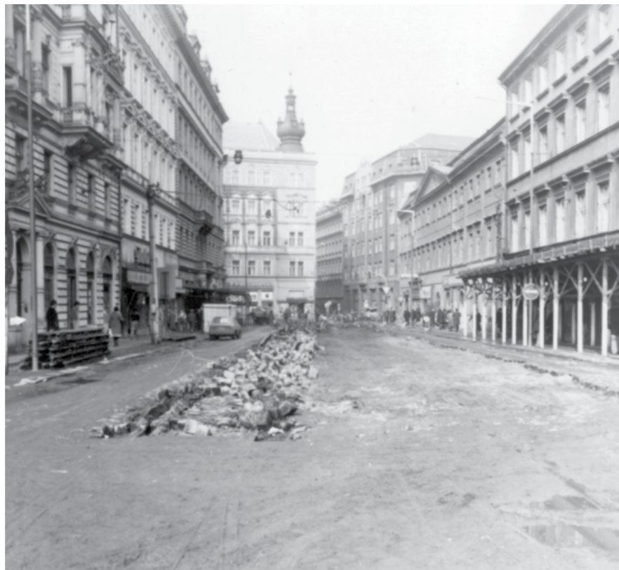
HAVLÍČKOVA SEVER NA SNÍMKU JIŘÍHO KIRNIGA (ARCHIV DPP) Z CCA POČÁTKU ROKU 1983. JE VIDĚT SNESENÁ DLAŽBA PRO VÝSTAVBU BUDOUCÍ TRATĚ Z BKV PANELŮ A V PÍSKU VÍCE VLEVO JEŠTĚ PŮVODNÍ ZBYTKY VÝHYBKY A KOLEJÍ VE STŘEDOVÉ POLOZE. NA TOMTO I NĚKOLIKA DALŠÍCH SNÍMCÍCH ZAUJMOU LAMPY TYPU „SOUDEK“ (ELEKTROPODNIK VS805), SVĚHO ČASU VELMI ROZŠÍŘENÉ, ZDE VŠAK JIŽ PŘED LIKVIDACÍ
